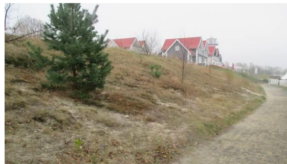
Foto 4: Böschung am Uferweg (M2a)
